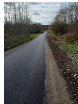
Droga Bieńkowice-Bojanów po remoncie
