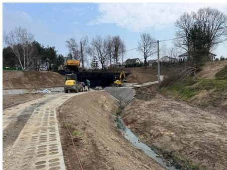
Prace na rowie H14 - budowa zbiornika retencyjnego
