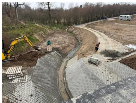
Prace na rowie H14 - budowa zbiornika retencyjnego
