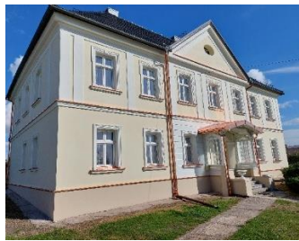
Plebania w Bieńkowicach po remoncie
