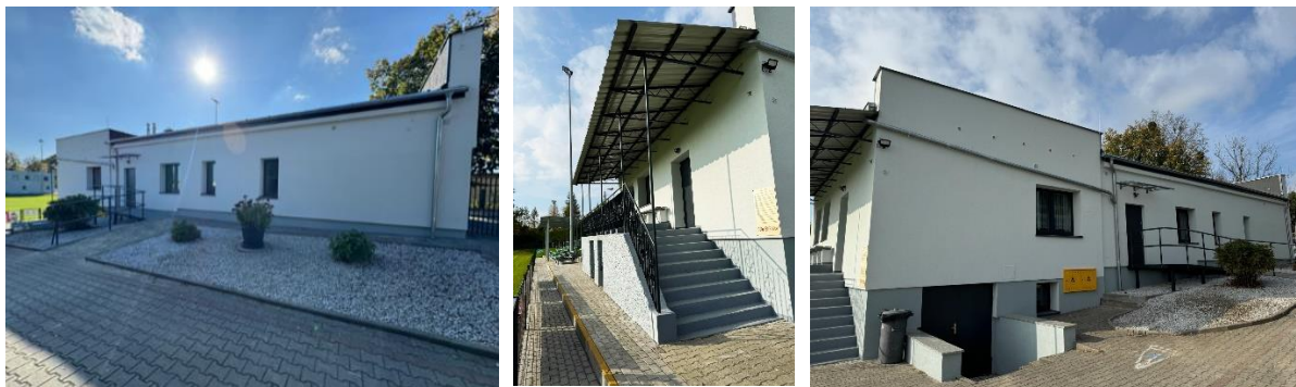
Budynek świetlicy po termomodernizacji
