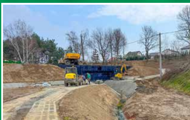
Budowa zbiornika retencyjnego na finiszu
